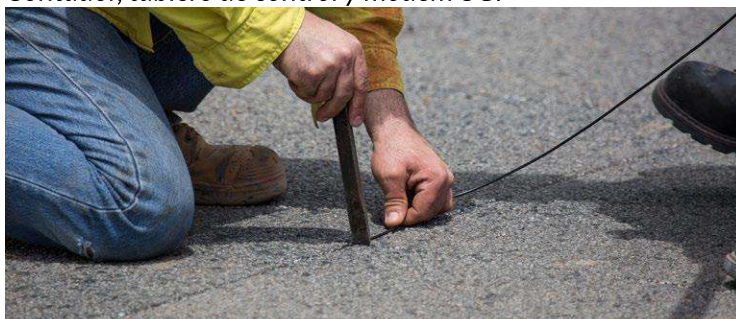
Instalación de los lazos inductivos.
