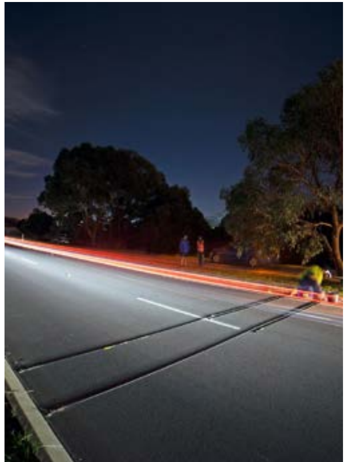
La configuración única del RoadPod VT4 usando mangueras corta y larga para monitorear carriles dobles.
