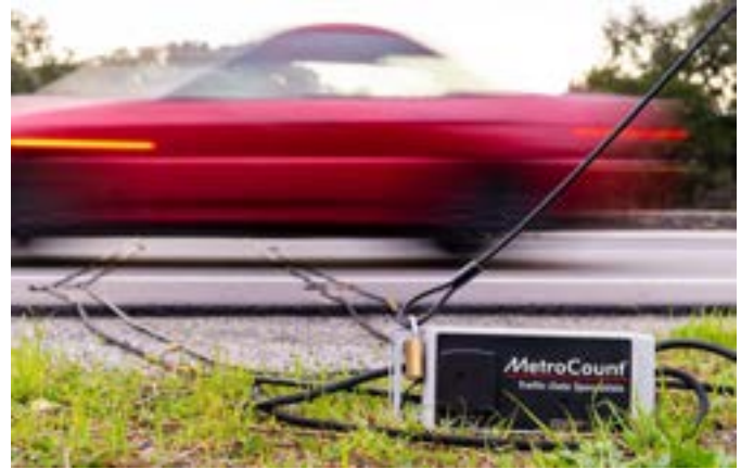
Instalacion de acceso remoto al Metrocount Roadpod VT4.
